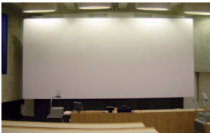
Kiinteä valkokangas VKK 260, sähköisesti kallistettava.
