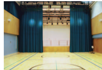
Esirippu puoliksi auki. Avataan ja suljetaan moottorin avulla.
