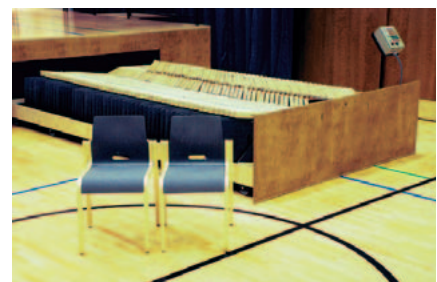
Näyttämön alla oleva tuolivaunu ulos vedettynä. Vaunussa säilytetään yleisötuoleja, tätä tuolimallia sopii jokaiseen vaunuun 100 kpl.
