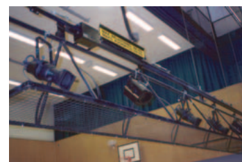
Sähkötoimiset VMK-ansaat valaisimien ripustamiseen, varustettu pallosuojaverkolla.
