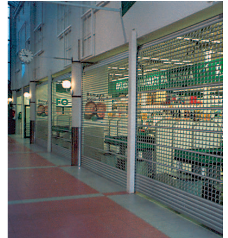
Kassalinjojen sulkeminen PX 60-75 -rullakaltrilla. Alas laskettu rullakalteri suljetun kassan edessä estää asiattomia läpikulkua. Prisma, Pietarsaari.
