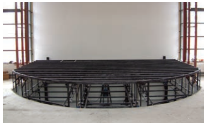
Nousevan ja laskevan näyttämön NN 9010 runko asennusvaiheessa. Näyttämön etureuna pyöreä.
