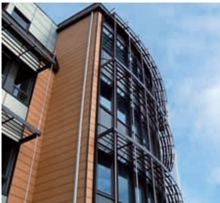
Aurinkosuoja- ja julkisivusäleikkö Sunblock 95, erikois rst-pystyputkijärjestelmällä. Teknologikeskus Alavus Fasadi, Alavus.
